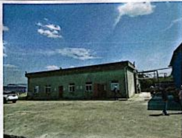
本公司已建项目污水处理站
