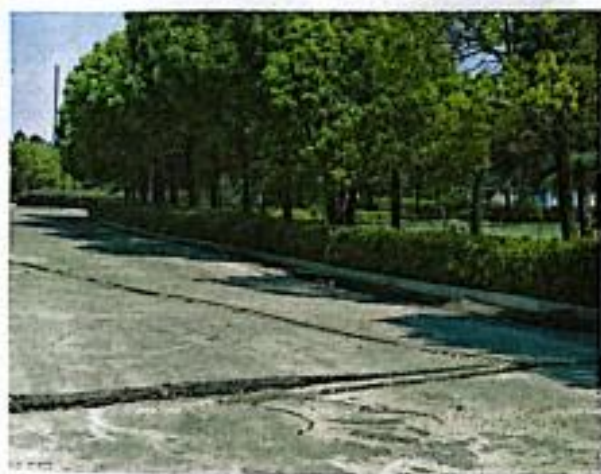
项目区雨水收集沟
