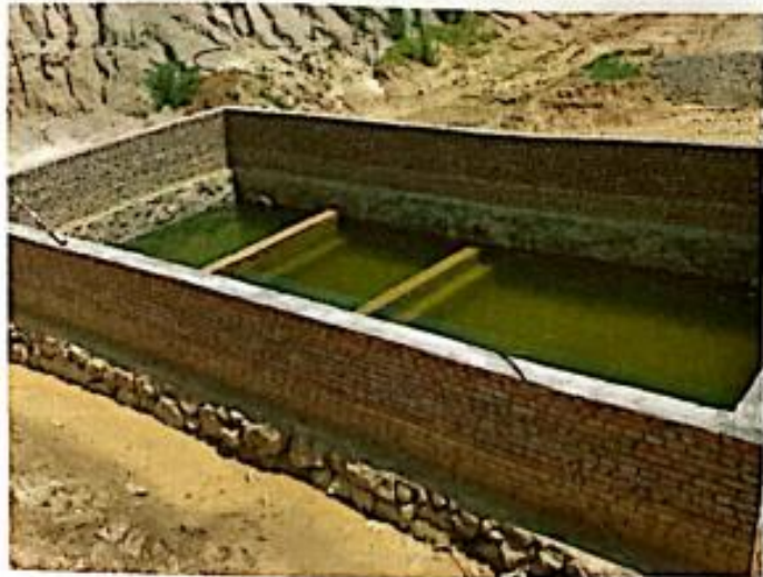
采石场雨水收集池
