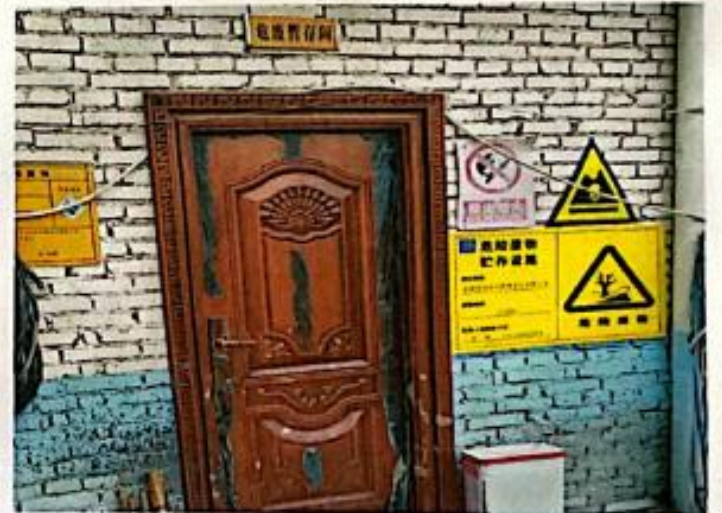
采石场危废暂存间
