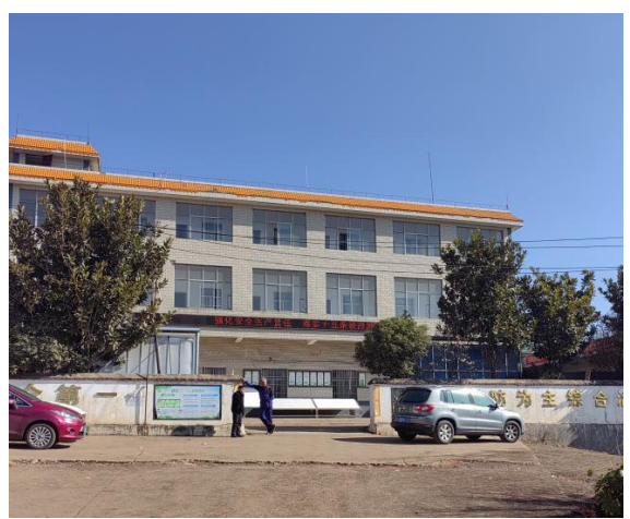
煤矿已建办公区
