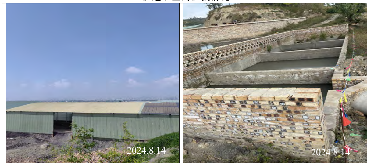
页岩矿堆场（依托工程）
