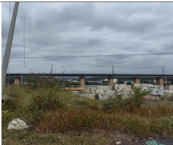
厂址北侧沪昆铁路
