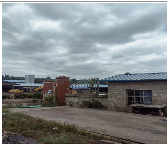
厂址北侧木材厂
