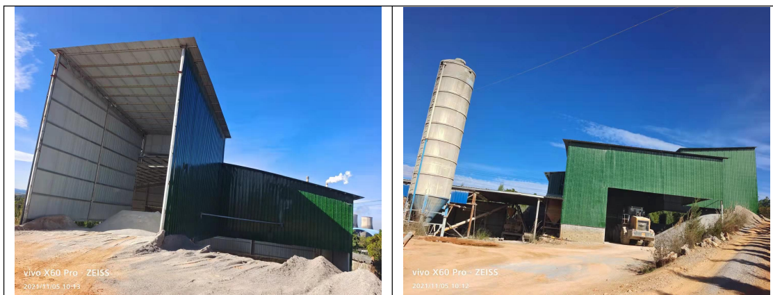
砂料堆场区实施封闭大棚建设
